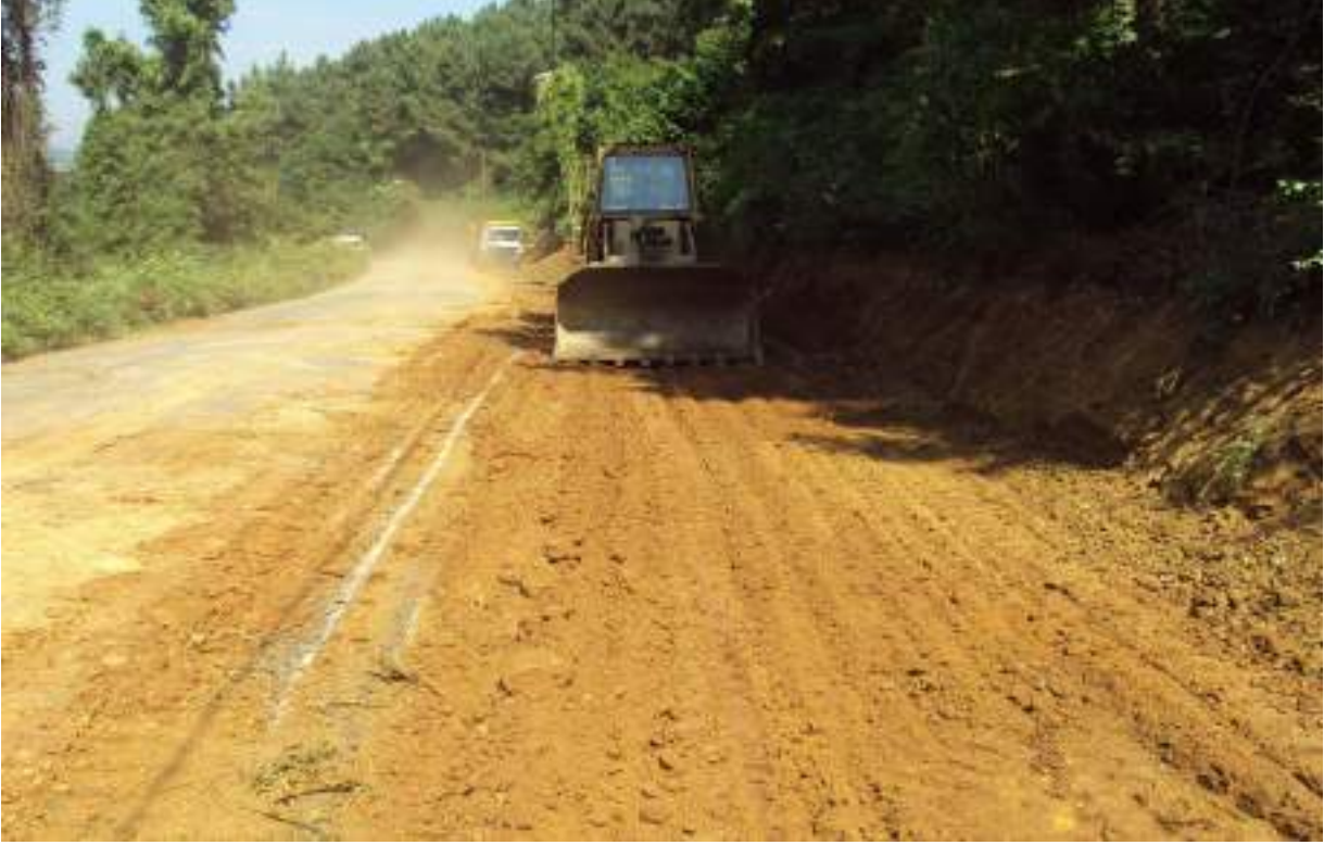
Yol ađının geniřletilmesi
