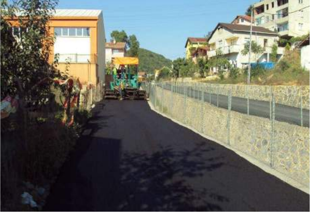
Asfalt Kaplama ve yama
