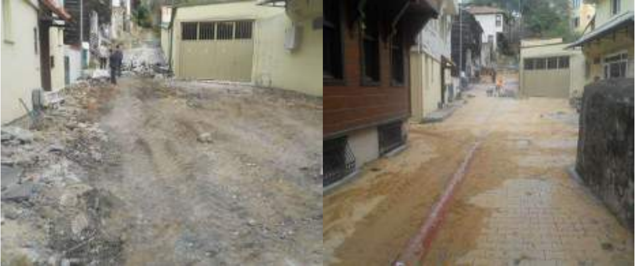
Kanlıca Fikirtepe Sokak Yol Çalışması
