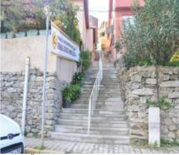
Göksu Özen Sokak Merdiven Çalışması
