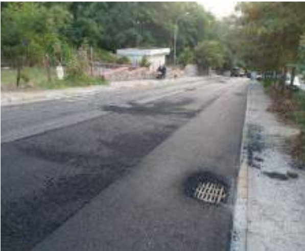
Gümüşsuyu Dereiçi Sokak Asfalt Çalışması
