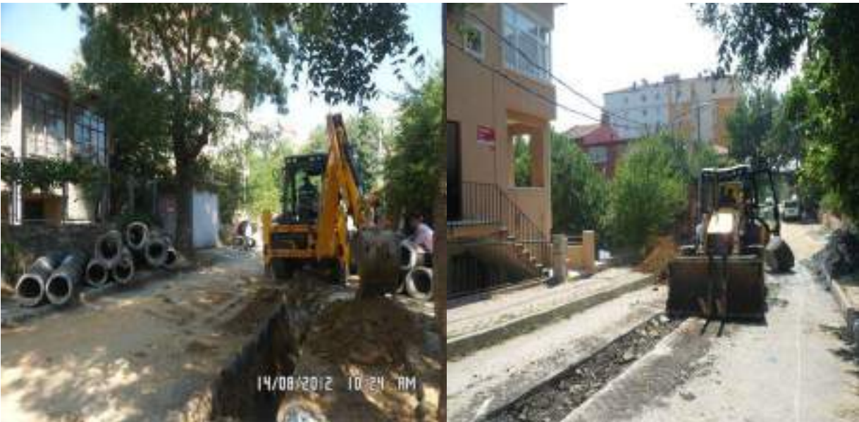
Kavacık Mahmureler Sokak Yağmursuyu Çalışması
