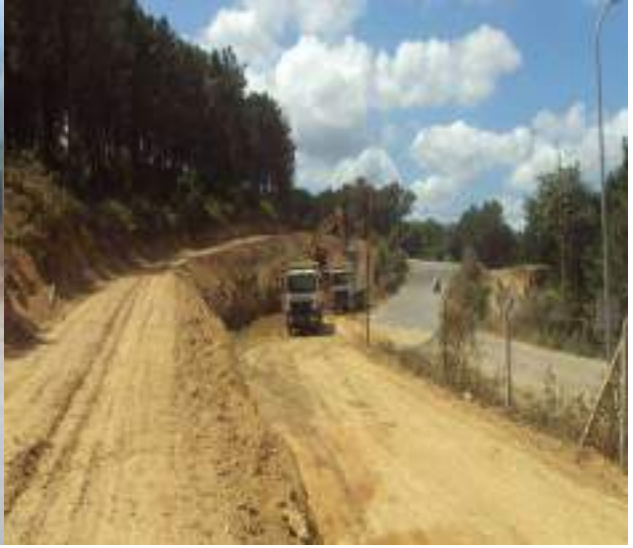
Çubuktaş Yol Açılması
