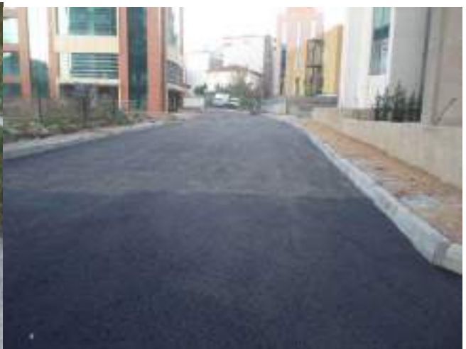
Kavacık Mevlana Sokak Asfalt Çalışması
