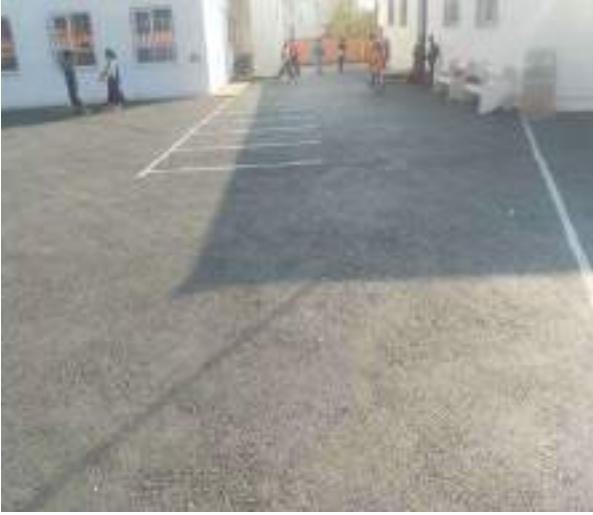
Okul Bahçesi Asfalt Çalışması
