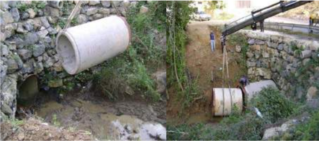
Yavuz Selim Mahallesi Karanlıkdere Caddesi Köprü Yükseltme Çalışması
