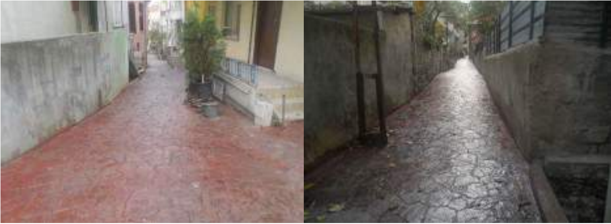
İncirköy Sümer Sokak Baskı Beton Uygulaması
