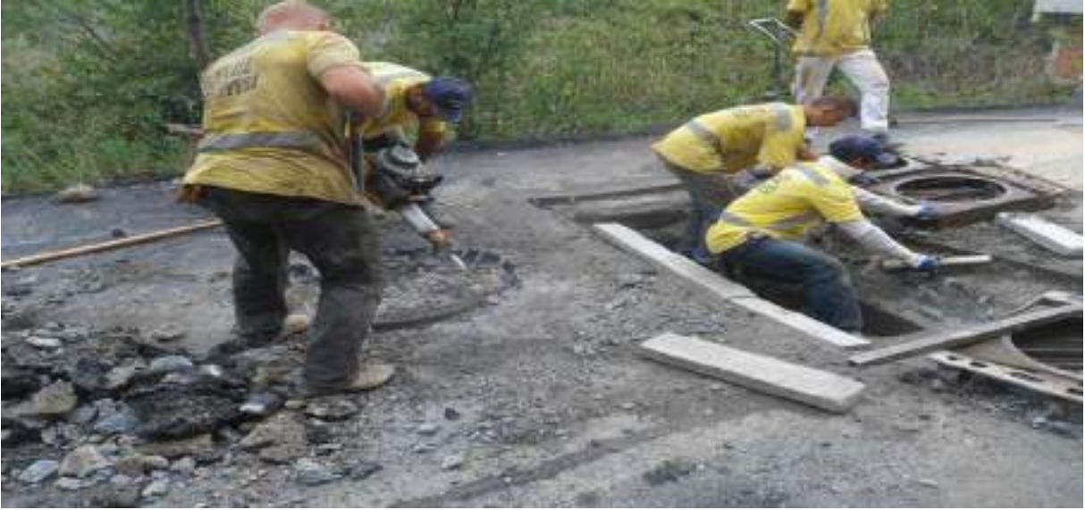
Gümüşsuyu Mahallesi Yağmur Suyu Izgara ve Baca Yükseltme Çalışması
