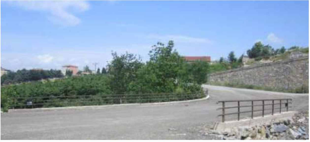
Baklacı Mahallesi, Ertuğrul Gazi Caddesinde Bulunan Köprünün Her İki Tarafına Yapılan Korkuluk Çalışması
