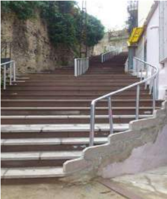
Merdiven Kaplama ve Korkuluk Yapımı
