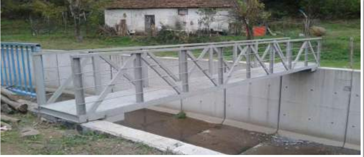
Mahmut Şevket Paşa Köyü, 1x8 m Ebadında Yapılan Yaya Köprüsü Çalışması
