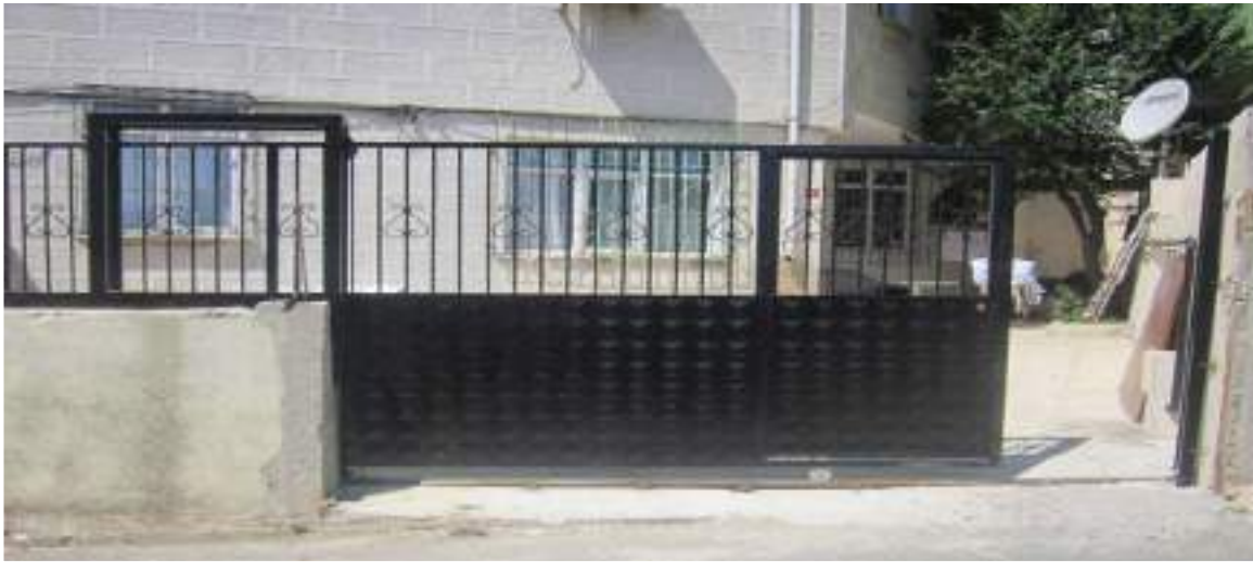
Hacı Yusuf Cami, Raylı Kapı Çalışması
