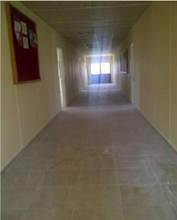
Kavacık Ortaokulu Prefabrik Bina Yapımı İşi
