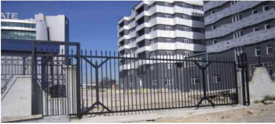
İlçe Emniyet Müdürlüğü Demir Kapı ve Cam Korkuluk Çalışması
