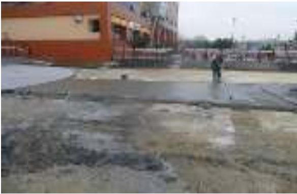
İlçe tören alanı baskı beton uygulması
