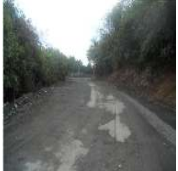
Anadolukavağı – Poyraz bağlantı yolu genişletme ve stabilize serimi
