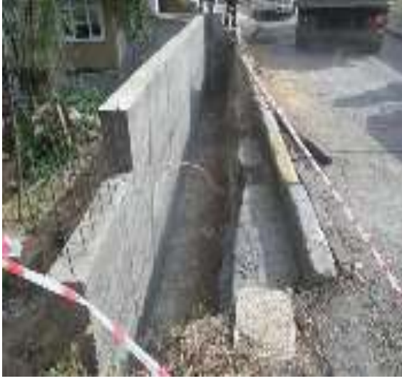
Çubuklu Mah.–NazımTurCad.Betonarme Duvar Yapımı Yapımı
