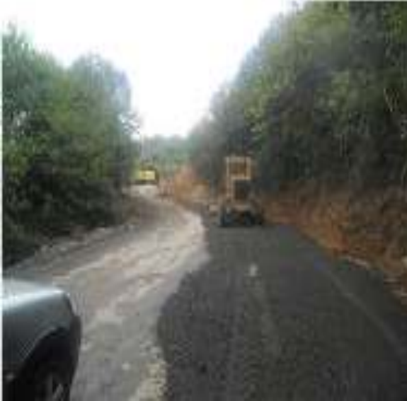
Anadolukavağı – Poyraz bağlantı yolu genişletme ve stabilize serimi
