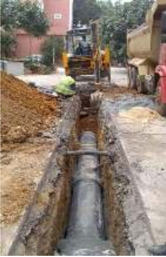
Kavacık Mah. – Nüve Sok. yağmursuyu kanalı yapım çalışmaları
