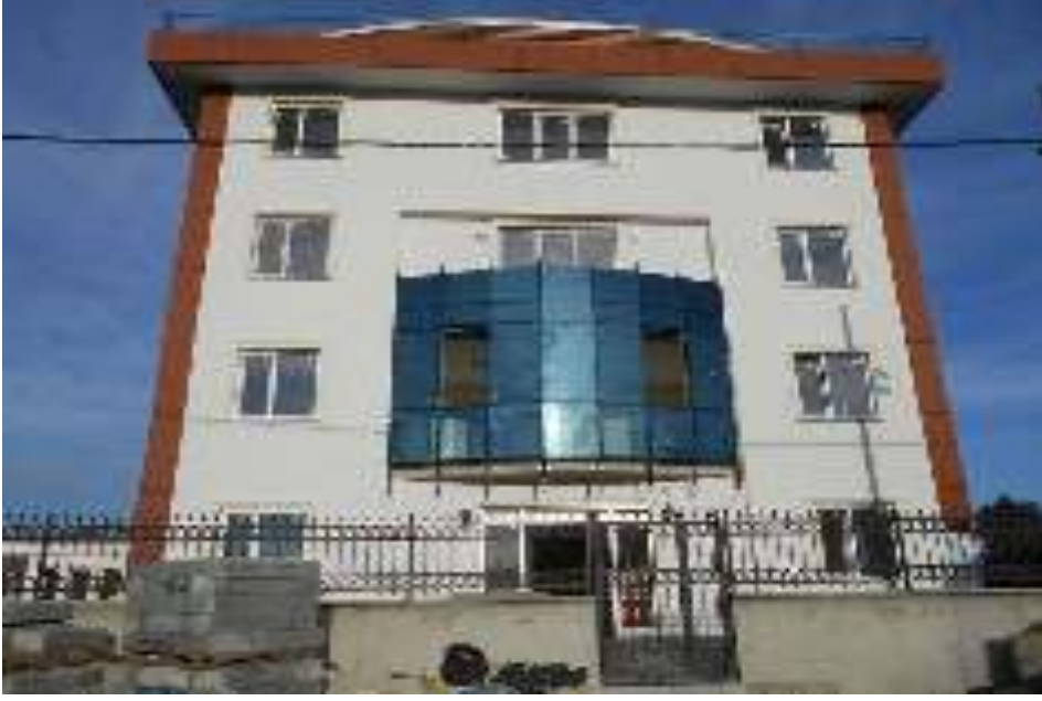
Yenimahalle Hizmet Binası
