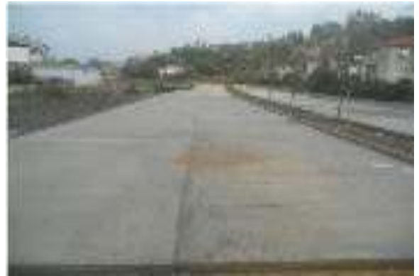
Göksu Mah. - Pazar yeri tesviyesi yapıldı ve zemin betonu döküldü
