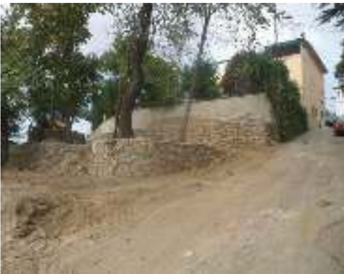
Kanlica Mah. Fıstıklı Yokuşu Taş Duvar Yapımı
