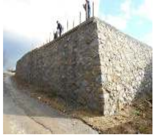
Bozhane–Ek Hizmet Binası Taş Duvar
